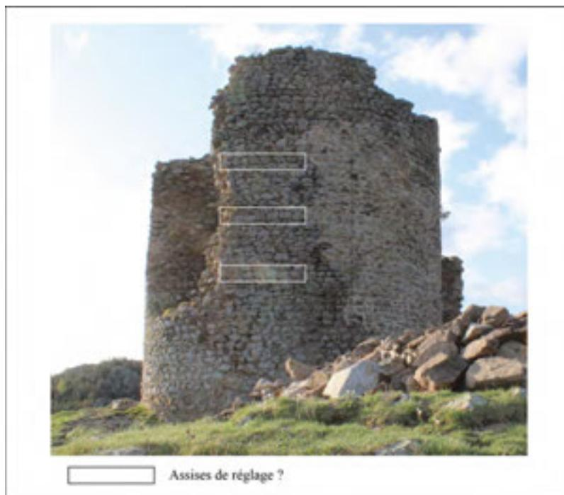
Figure 42 : Localisation des probables assises de réglage dans l'élévation de la tour.
